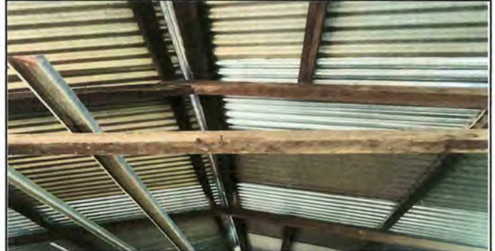
Foto 2: Se observa el deterioro de las costaneras de la cocina.
