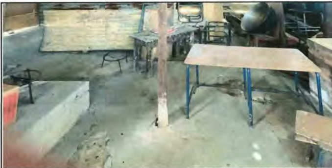
Foto 5: Se observa la necesidad de la reparacion del piso de torta de concreto.
