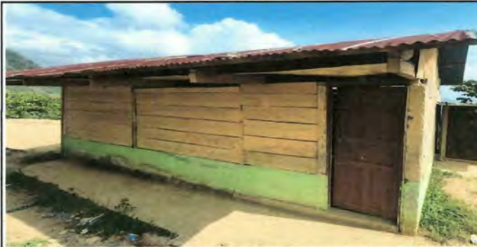
Foto 3: Se observa la necesidad de la sustitucion de la puerta de la cocina
