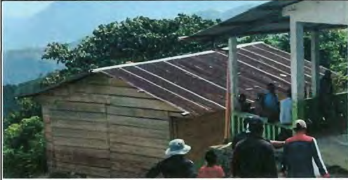
Foto 1: Se observa el deterioro de las laminas del techo de la cocina.
